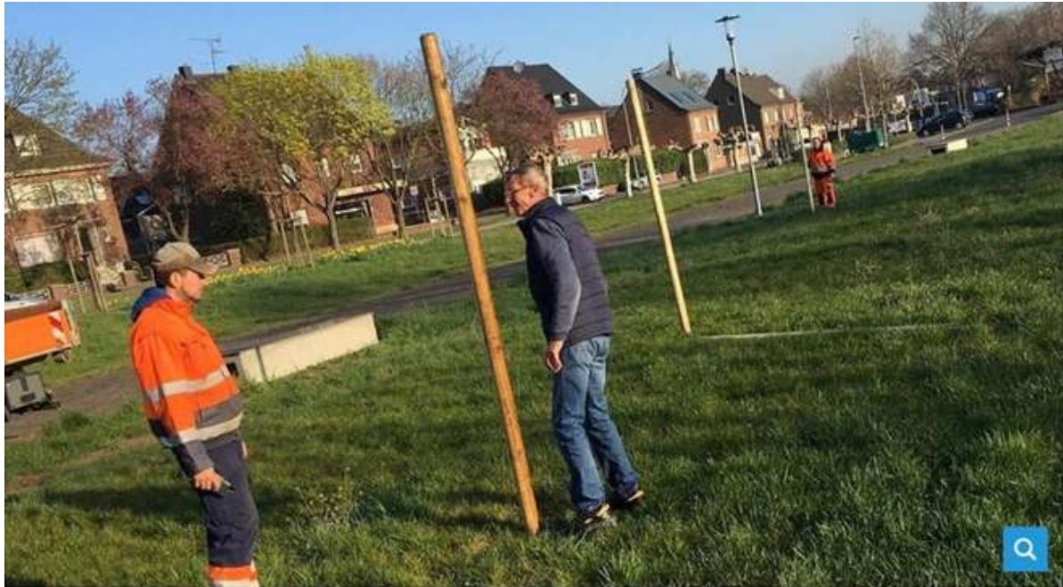
Arbeiten auf der Ladestraße in der Nähe des Bahnhofs: Auf dem ehemals verwahrlosten Gelände wurden neue Laternen errichtet. Foto: Gindorf e.V.
